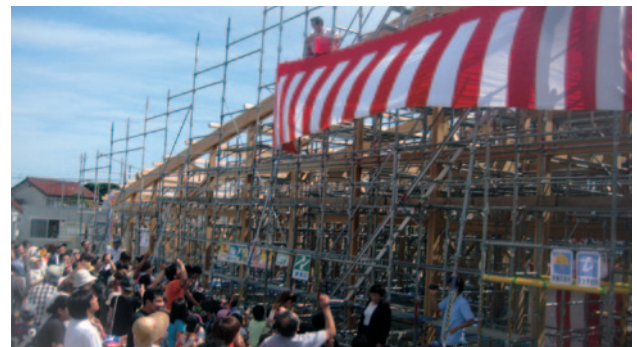
亶理町児童福祉施設の上棟式には、地元の人も参加し、工事が無事に進んでいることを感謝し、無事完成を祈願した
