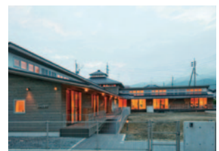
8. 井内保育所（宮城県石巻市） 延床面積700㎡。震災後の同市で当時最大の工事となった
