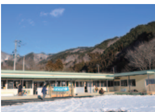
5. みどり幼稚園（岩手県大槌町） 内陸の自然豊かな地域に建設された仮設園舎
